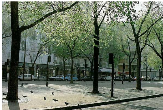
Place publique en sol en stabilisé (Paris)
