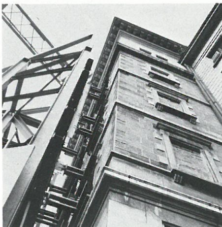
Vue sous le même angle, pile et face... Le maintien artificiel de la façade (immeuble Camoletti, rue de la Corratérie).
