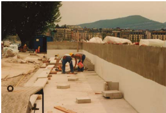
Fig. 133. Réparation dalles toiture
