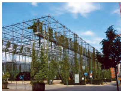
Structure métallique (ici MFO PARK à Oerlikon)
