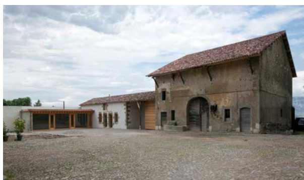
5a et 5b. Restauration et transformation du Domaine Penet à Chouilly par l'atelier ar-ter (photo O. Zimmermann)
