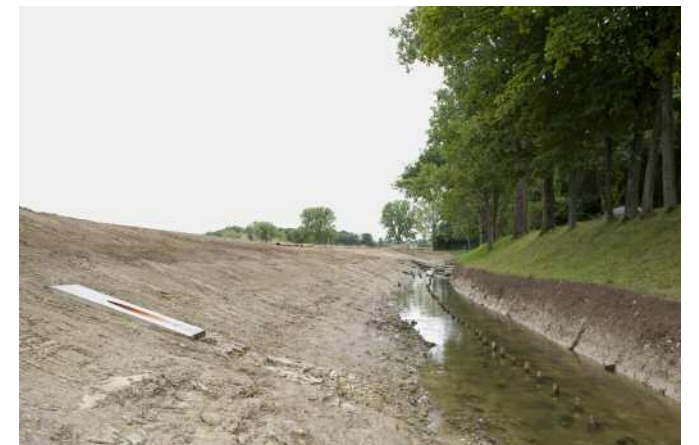
Abaissement de la berge rive droite, tronçon de la deuxième étape des travaux.
