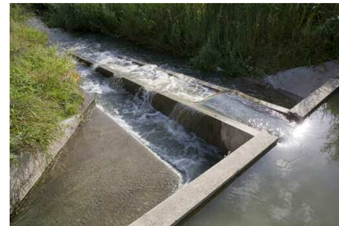
Ouvrage de régulation du niveau des marais (Sionnet et pré de l'Oie) au pont de Sionnet.
