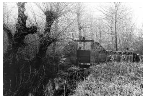
Ecluse au bas du marais de Sionnet en 1918 avant les travaux d'assainissement.
