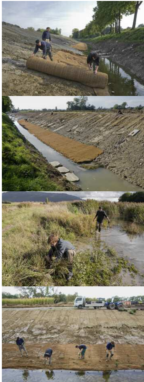
Nouveau profil du cours d'eau du tronçon de la deuxième étape, plantation d'hélophytes sur tissu végétal.
