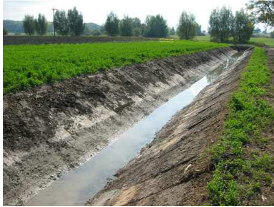
A GAUCHE Remise à ciel ouvert du nant de Compois. A DROITE Franchissement à la confluence de la Touvière et du nant de Compois.
