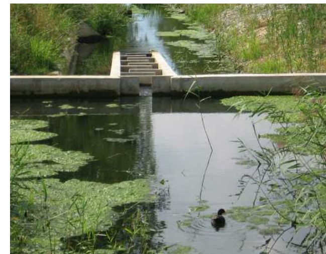
Retenue du niveau 426,50 pour le marais, combinée avec l'échelle à poisson.
