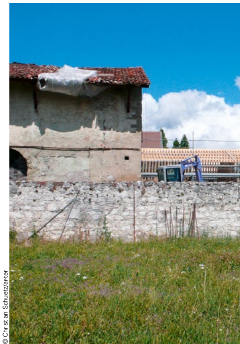
Fig. 3 Restauration de toiture en tuiles canal /courbe.
