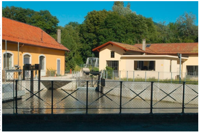
Fig. 7 Couvertures des toits du site des Berges de Vessy.
