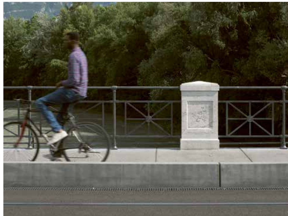
5 Nouveau tablier, nouveaux trottoirs et nouvelles circulations du pont Neue Brückentafel, neue Trottoirs und neue Verkehrsregelung
