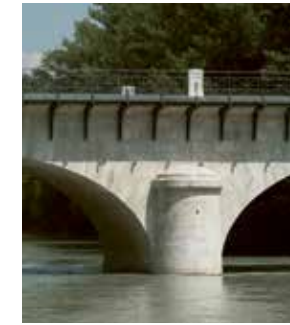
Rénovation d'un pont historique Erneuerung einer historischen Brücke Carouge (GE), 1982–2017 → Page/Seite 38
